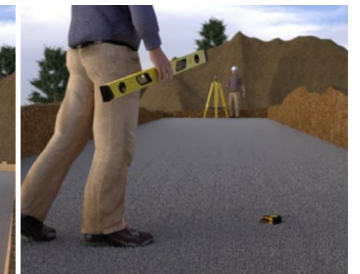
Проверка уровня высот закладных деталей
