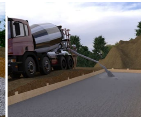
Укладка фундаментных плит или заливка бетонного основания
