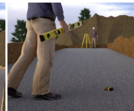
Проверка уровня высот закладных деталей
