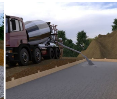
Укладка фундаментных плит или заливка бетонного основания
