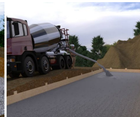
Укладка фундаментных плит или заливка бетонного основания
