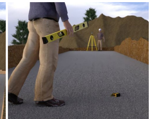
Проверка уровня высот закладных деталей
